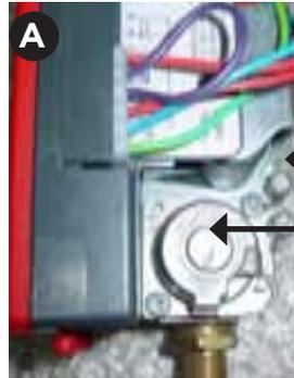
● Prüfstelle für den Eingangsdruck
